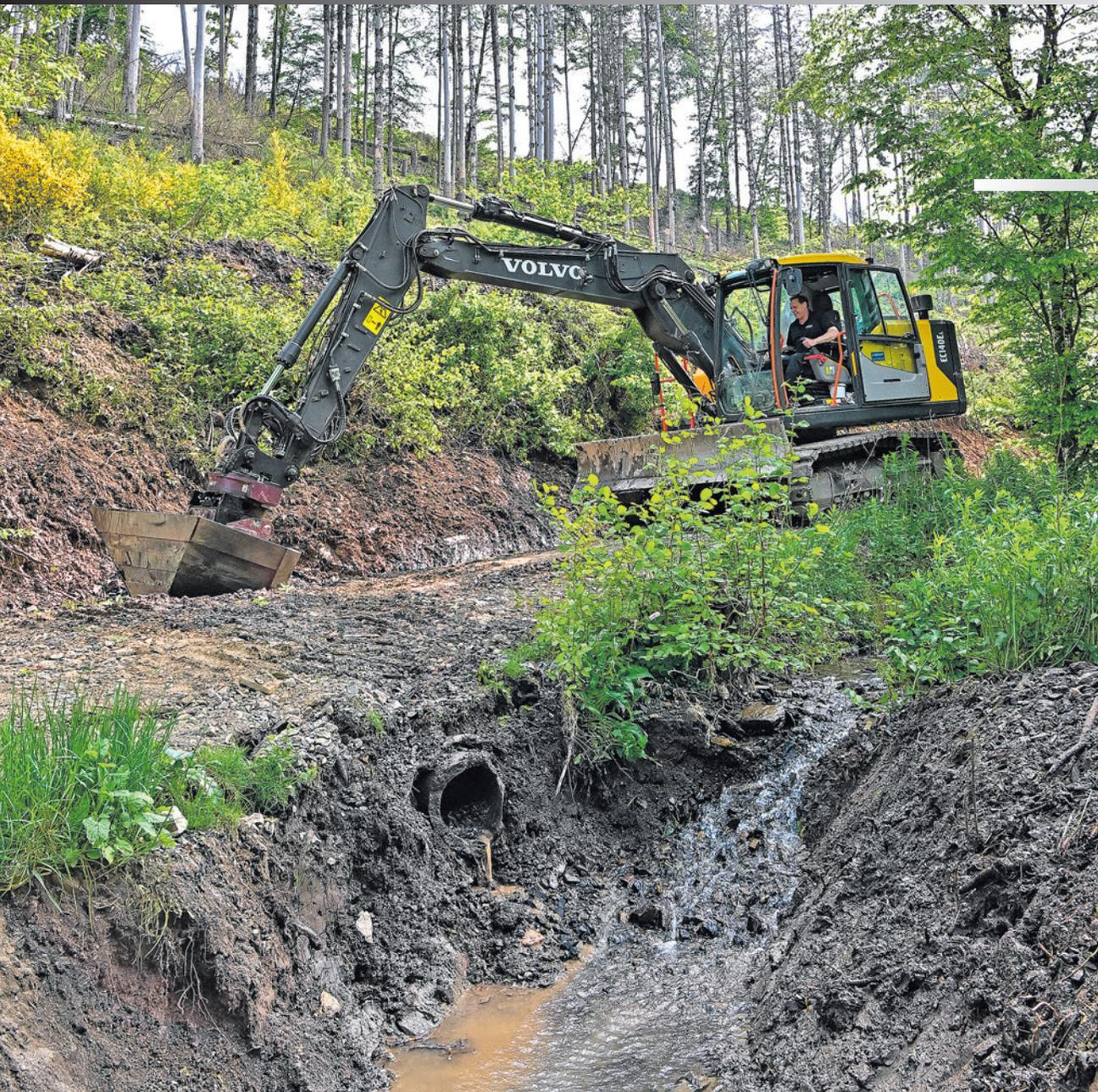
Mit einem speziellen „Grabenlöffel“ an seinem Bagger sorgt Pfau-Mitarbeiter Markus Köhler dafür, dass der Metzbach abfließen kann und der Weg wieder gut passierbar wird. Das eigentlich kleine Gewässer spülte beim sintflutartigen Unwetter in Daaden im Kreis Altenkirchen vor zehn Wochen große Mengen Matsch und Geröll mit ins im Tal liegende Gewerbegebiet. Pfau hat kurzfristig geholfen, die Folgen der Überschwemmung zu beseitigen.
