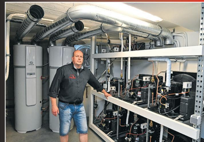
Neue Kühlaggregate hat Dirk Schmidt bereits – allerdings sind sie nicht mehr im Keller untergebracht. Per Wärmerückgewinnung wird deren Abwärme zum Heizen des Spülwassers genutzt.
